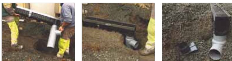
Setting an Ekso sump unit
